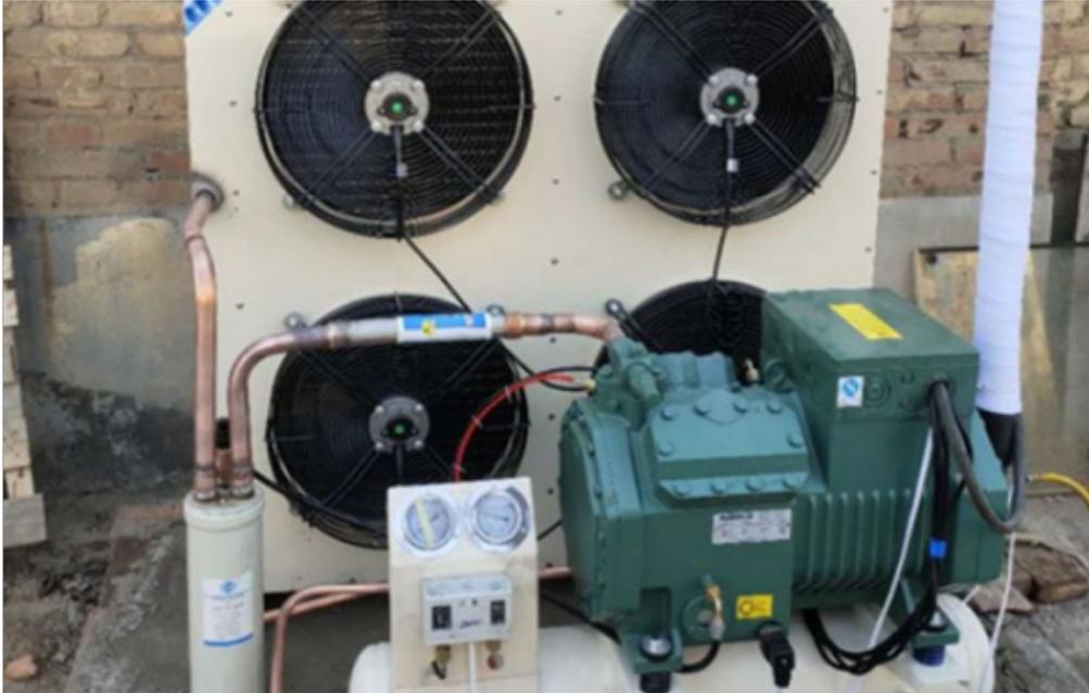
制冷设备，是指主要用于船员食物冷藏、各类货物冷藏及暑天的舱室空气调节的设备。主要由压缩机、膨胀阀、蒸发器、冷凝器和附件、管路组成。按工作原理可分为压缩制冷设备、吸收制冷设备、蒸汽喷射制冷设备、热泵制冷设备和电热制冷装置等。船舶上应用普遍的是压缩制冷设备。通过设备的工作循环将物体及其周围的热量移出，造成并维持一定的低温状态。所用的制冷剂主要是氟里昂和氨，尤以氟里昂使用多。但由于氟里昂对大气臭氧层的破坏作用，已经开始受到环保条例的制约。氨及其他新型冷剂正被重新采用和试制中。制冷设备是制冷机与使用冷量的设施结合在一起的装置。设计和建造制冷装置，是为了有效地使用冷量来冷藏食品或其他物品；在低温下进行产品的性能试验和科学研究试验；在工业生产中实现某些冷却过程，或者进行空气调节。物品在冷却或冻结时要放出一定的热量，制冷装置的围护结构在使用时也会传入一定的热量。因此为保持制冷装置中的低温条件，就必须装设制冷机，以便连续不断地移去这些热量，或者利用冰的熔化或干冰的升华吸收这些热量。
